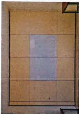
ישיבת לב התורה בית שמש מחיצה כניסור פורמאיקה בשילוב לוח חתיק.
